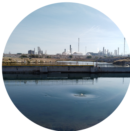
Zone industrielle de Fos sur Mer
